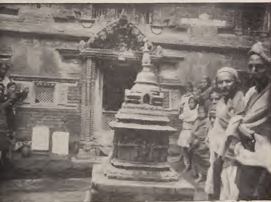
Cour délabrée d'un vihâra (Asan tol) à Katmandou.
